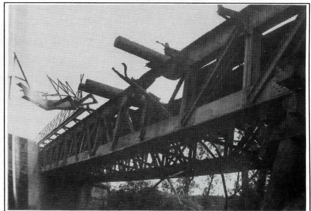
38. Le 30 juin 1944, lendemain de sa remise en service, le pont de Nâron est saboté pour la seconde fois.
