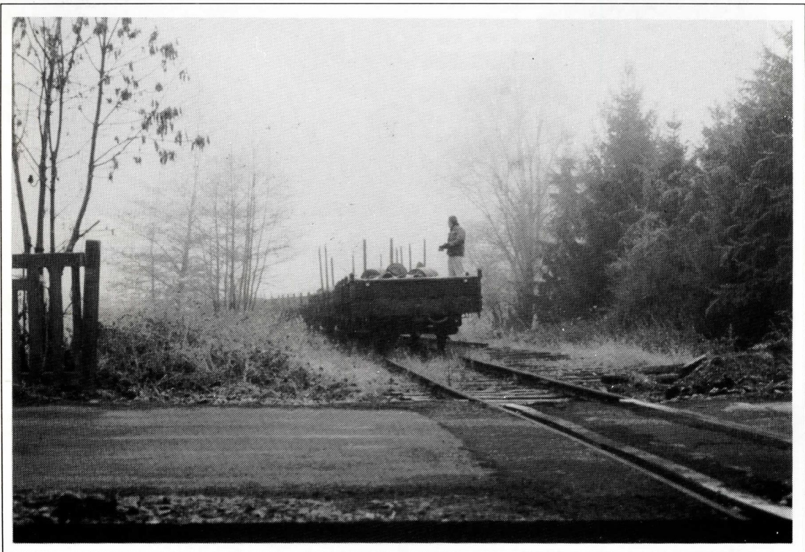
44. Novembre 1983: démontage définitif de la "ligne de la Lesse" ...
