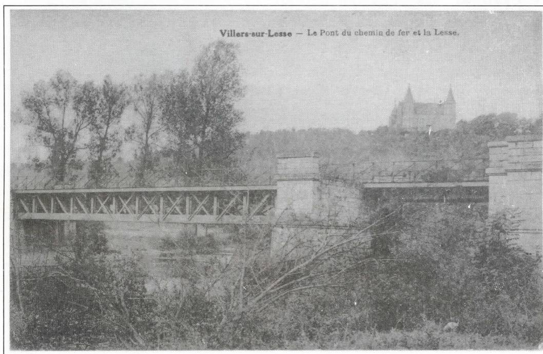
8. Le pont-rail de Nâron enjambant la Lesse au pied du château royal de Ciergnon.
